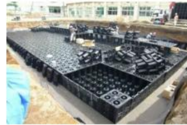
校庭下に設置する浸透・貯留槽
